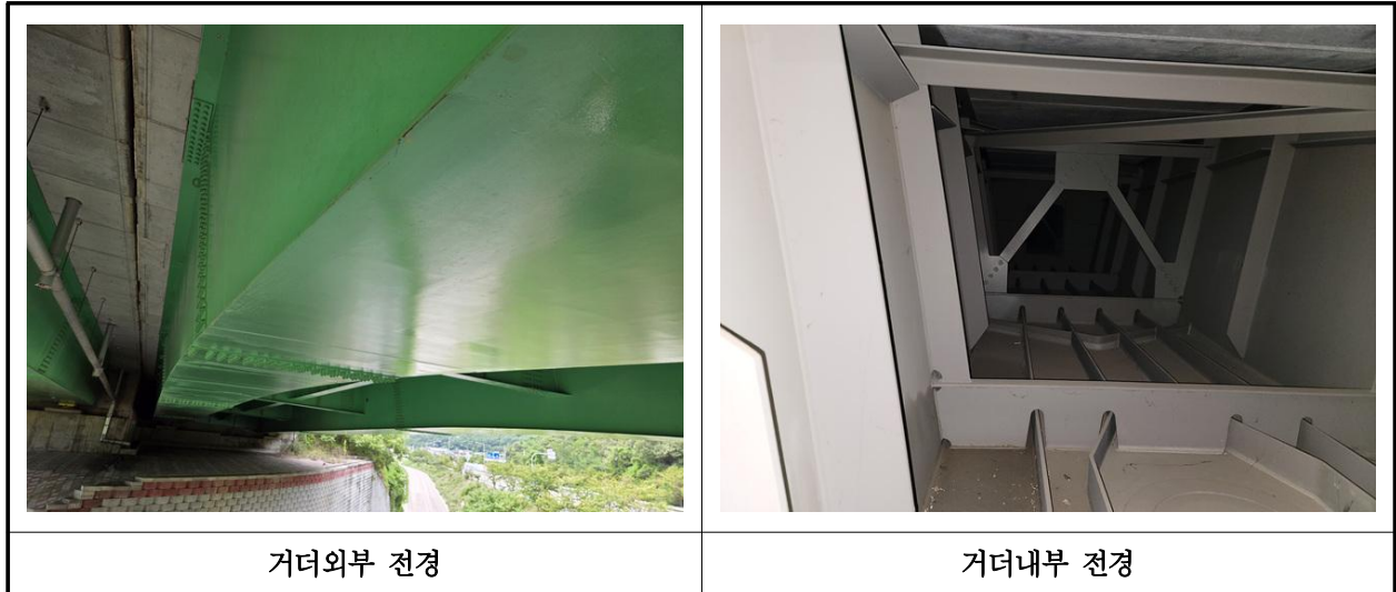
【사진 19.3.4】 거더 전경
