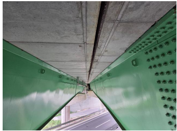
바닥관하면 S2 내측 캔틸레버 상태현황
