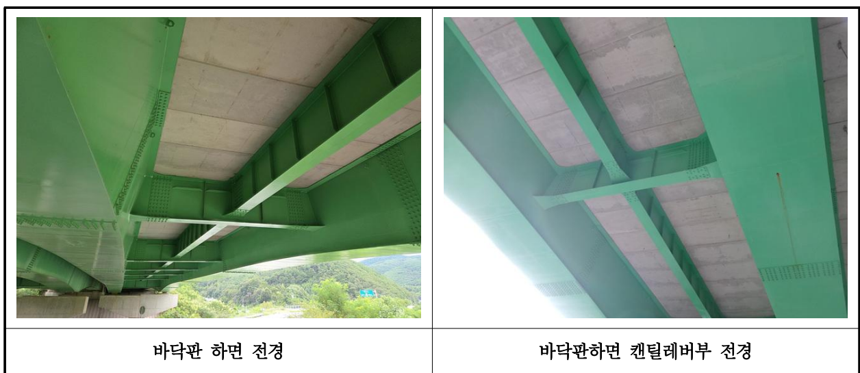
【사진 19.3.28】 바닥판하면 전경
