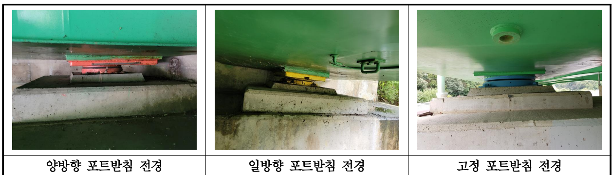
【사진 19.3.12】 교량받침 전경
