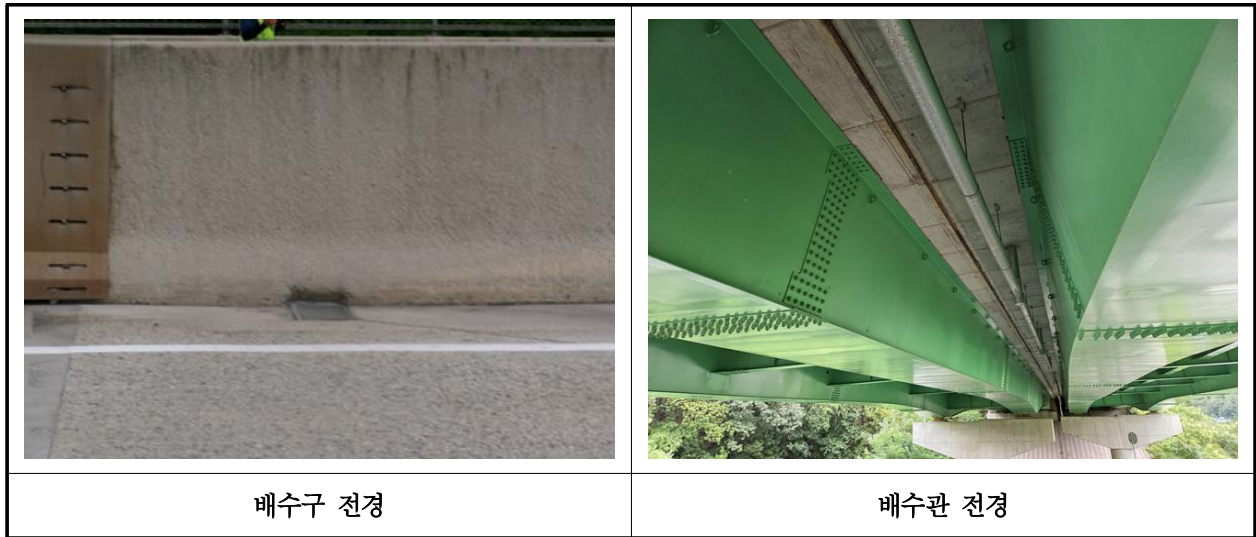
【사진 19.3.48】 배수시설 전경
