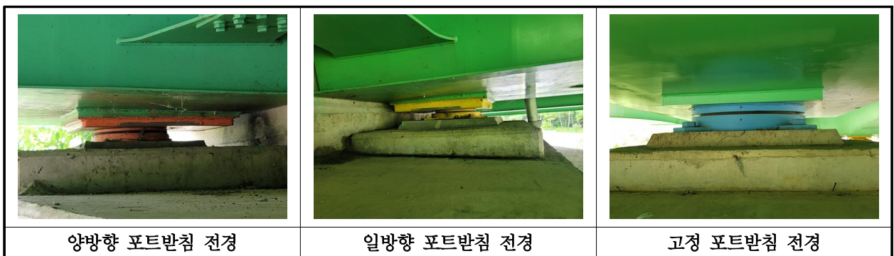
【사진 19.3.39】 교량받침 전경
