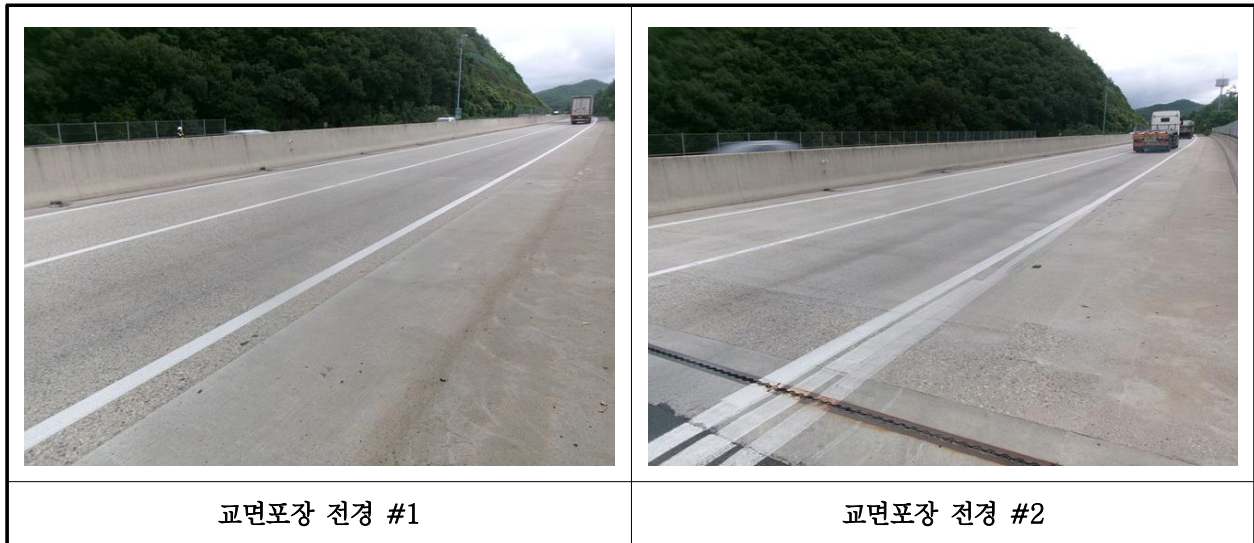
【사진 19.3.46】 교면포장 전경
