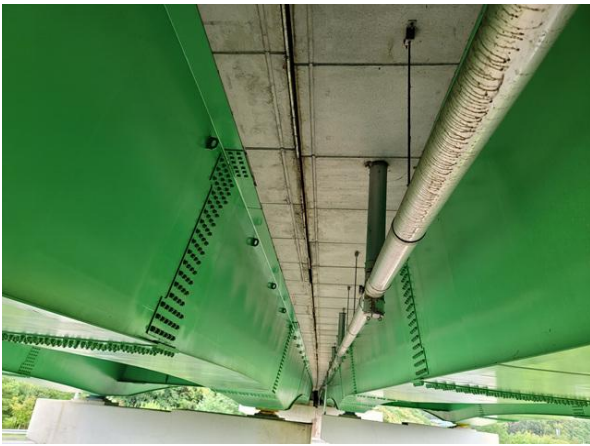
바닥관하면 S1 내측 캔틸레버 상태현황
