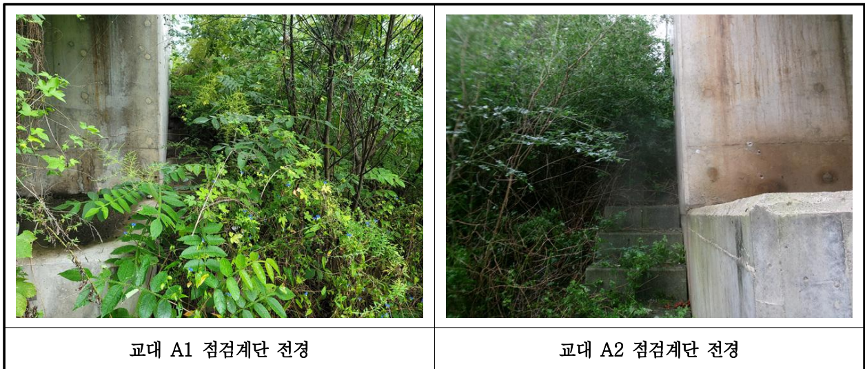
【사진 19.3.25】 교량 점검시설 전경
