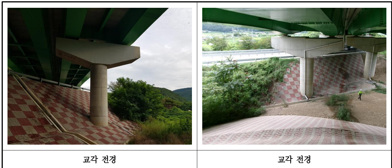
【사진 19.3.36】 교각 전경
