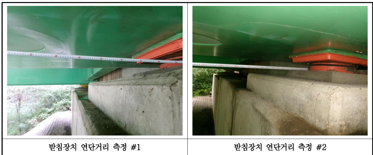
【사진 19.3.14】 교량받침장치 연단거리측정
