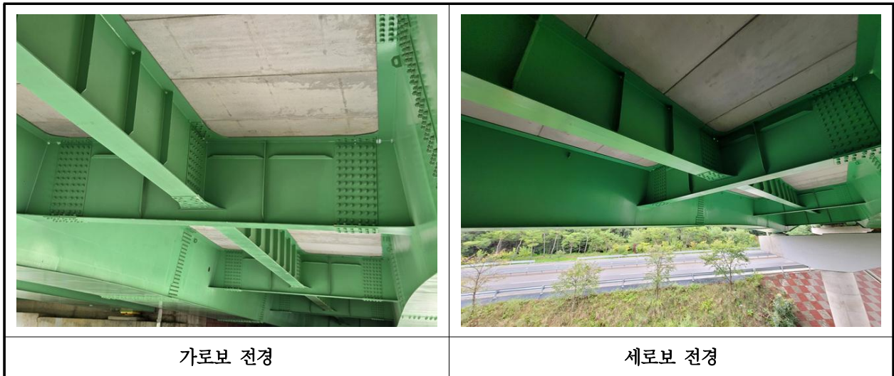
【사진 19.3.6】 가로보 및 세로보 전경
