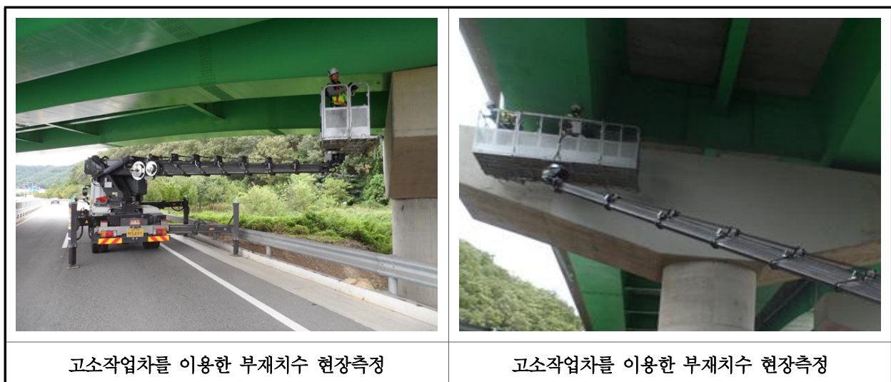
【사진 19.2.1】 부재 현장측정 전경
