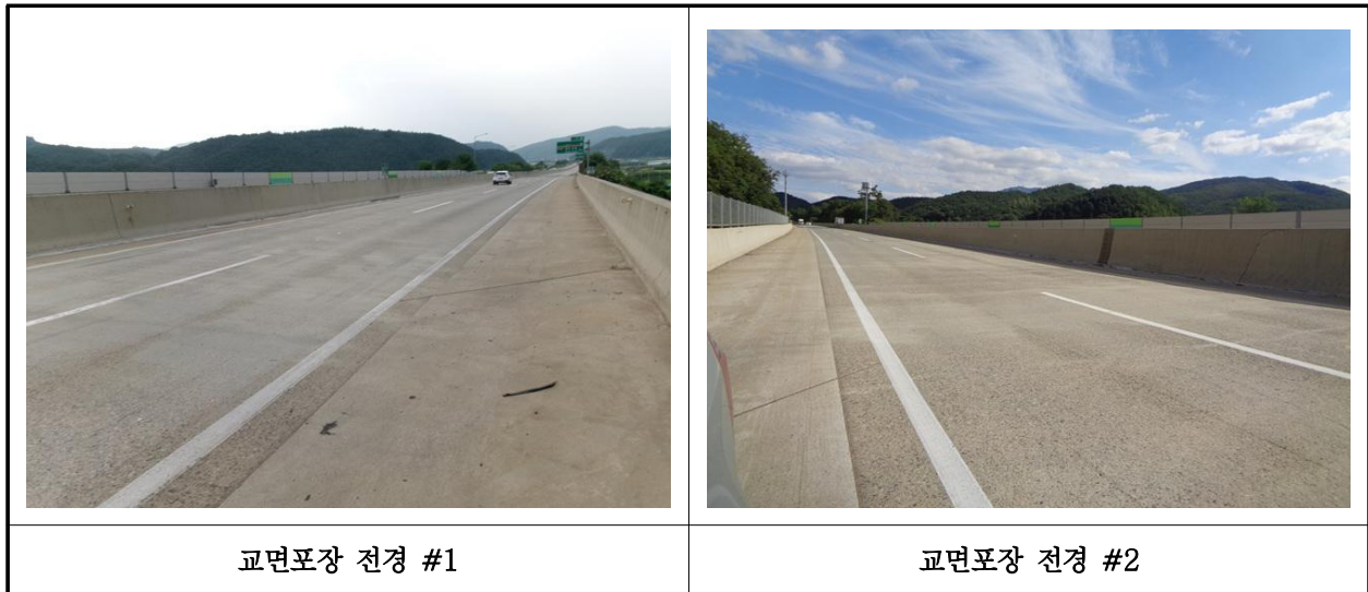
【사진 19.3.19】 교면포장 전경
