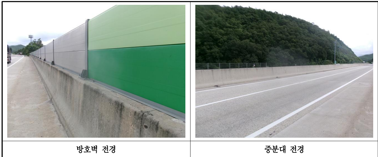
【사진 19.3.50】 방호벽 및 중분대 전경
