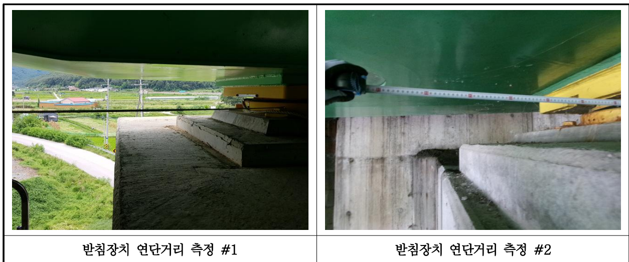
【사진 19.3.41】 교량받침장치 연단거리측정
