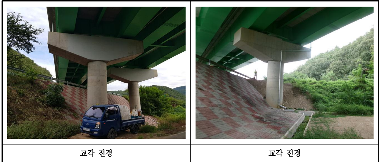
【사진 19.3.10】 교각 전경
