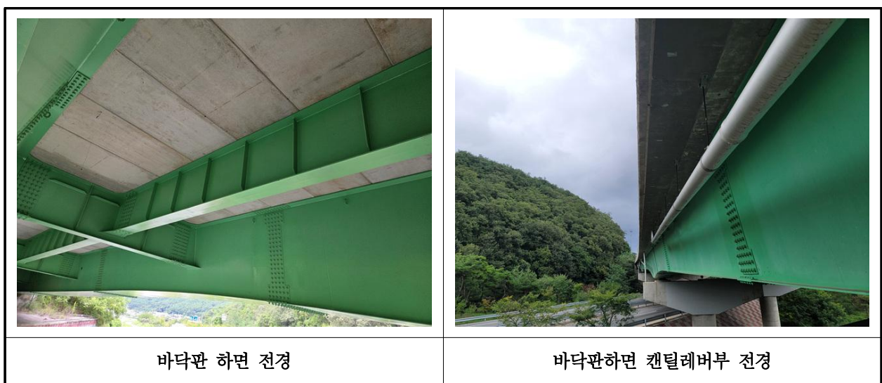
【사진 19.3.2】 바닥판하면 전경
