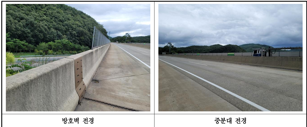
【사진 19.3.23】 방호벽 및 중분대 전경
