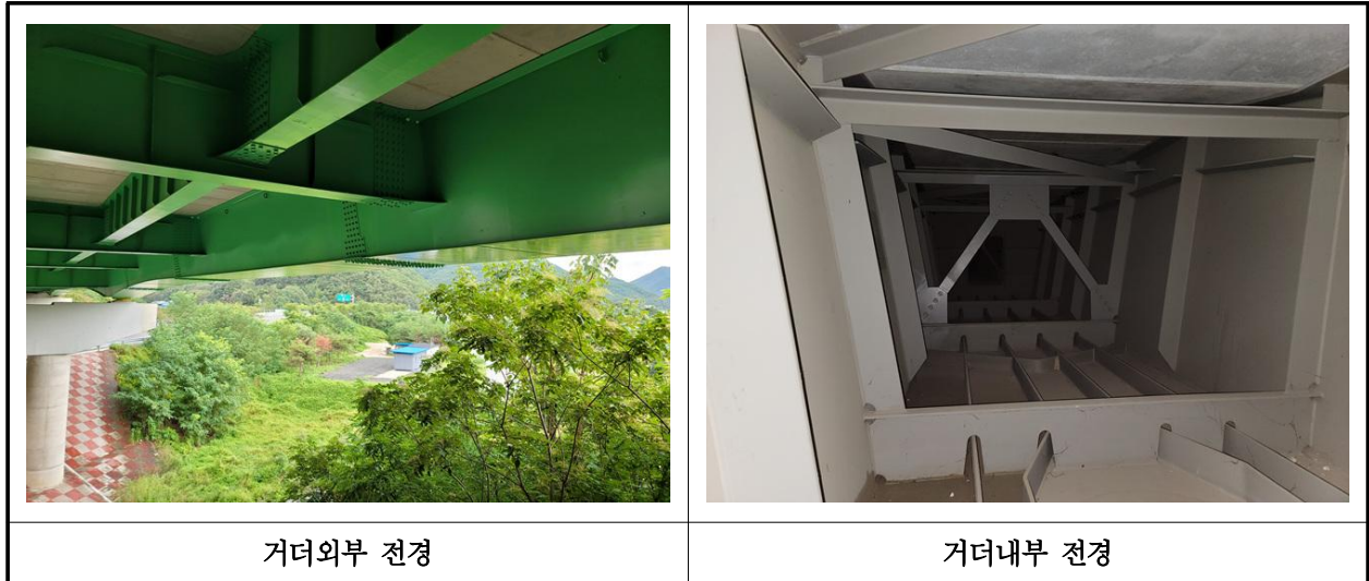
【사진 19.3.30】 거더 전경
