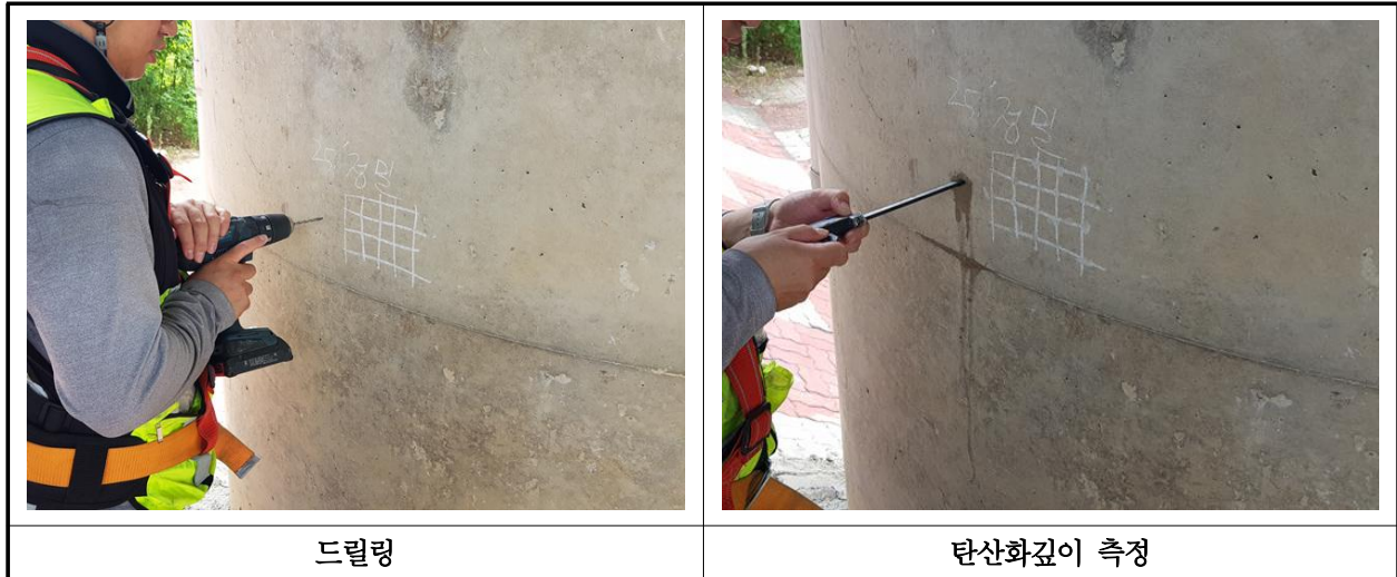
【사진 19.4.3】 탄산화 깊이 측정 현장사진
