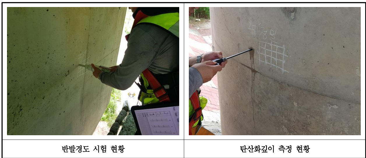
【사진 19.4.1】 콘크리트 내구성조사 현황
