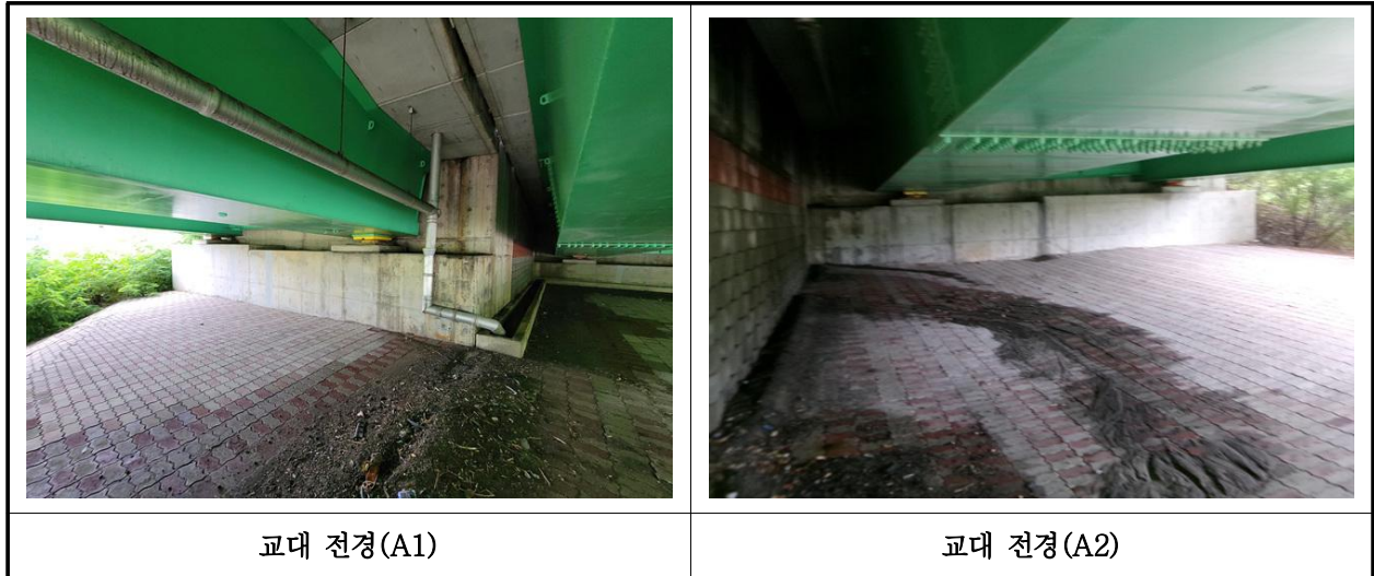
【사진 19.3.34】 교대 전경
