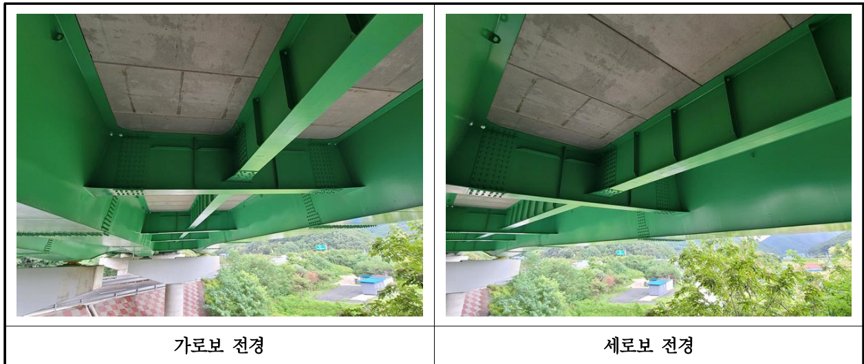
【사진 19.3.32】 가로보 및 세로보 전경
