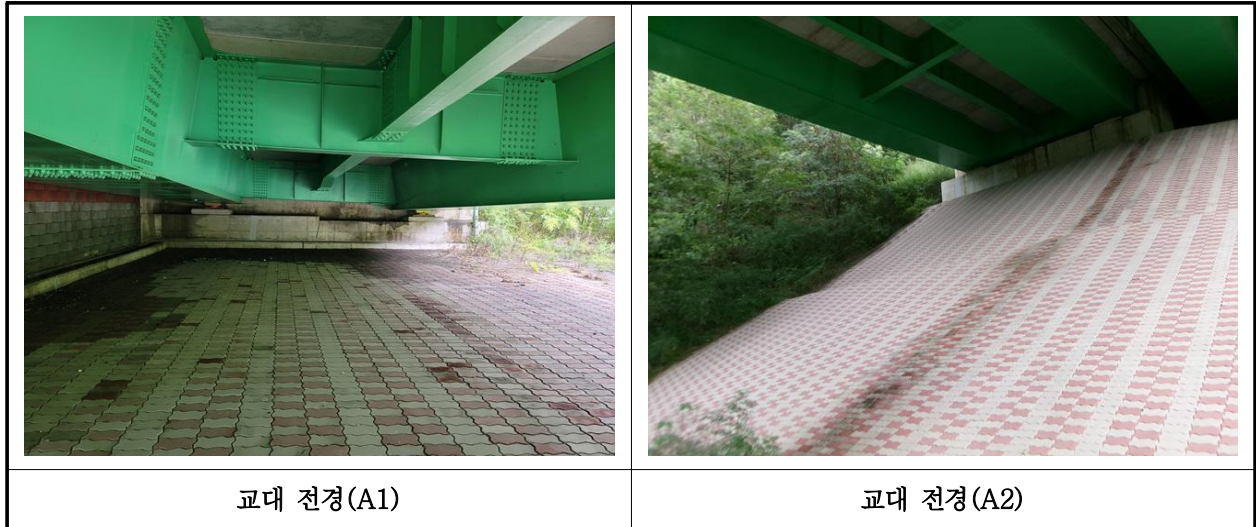
【사진 19.3.8】 교대 전경
